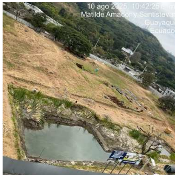
Foto 10 de agosto 10 am, bomba funcionando.
