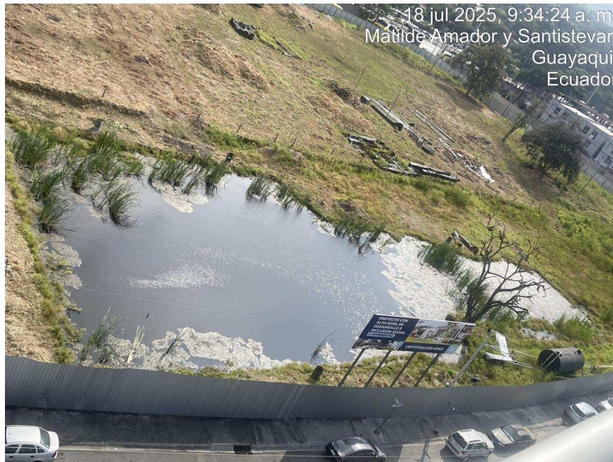
Foto C1: cantidad de agua acumulada el 18 de julio del 2025.
